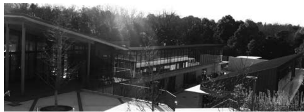
▲2024年4月に完成した新・彫刻専攻棟
